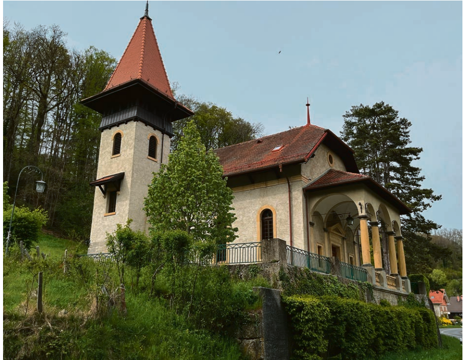
La chapelle des Monts de Corsier, un lieu de paix toujours ouvert. @Luc Badoux
