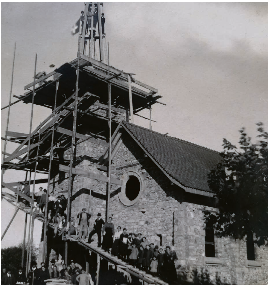
Le temple de Poliez-Pittet en construction.
